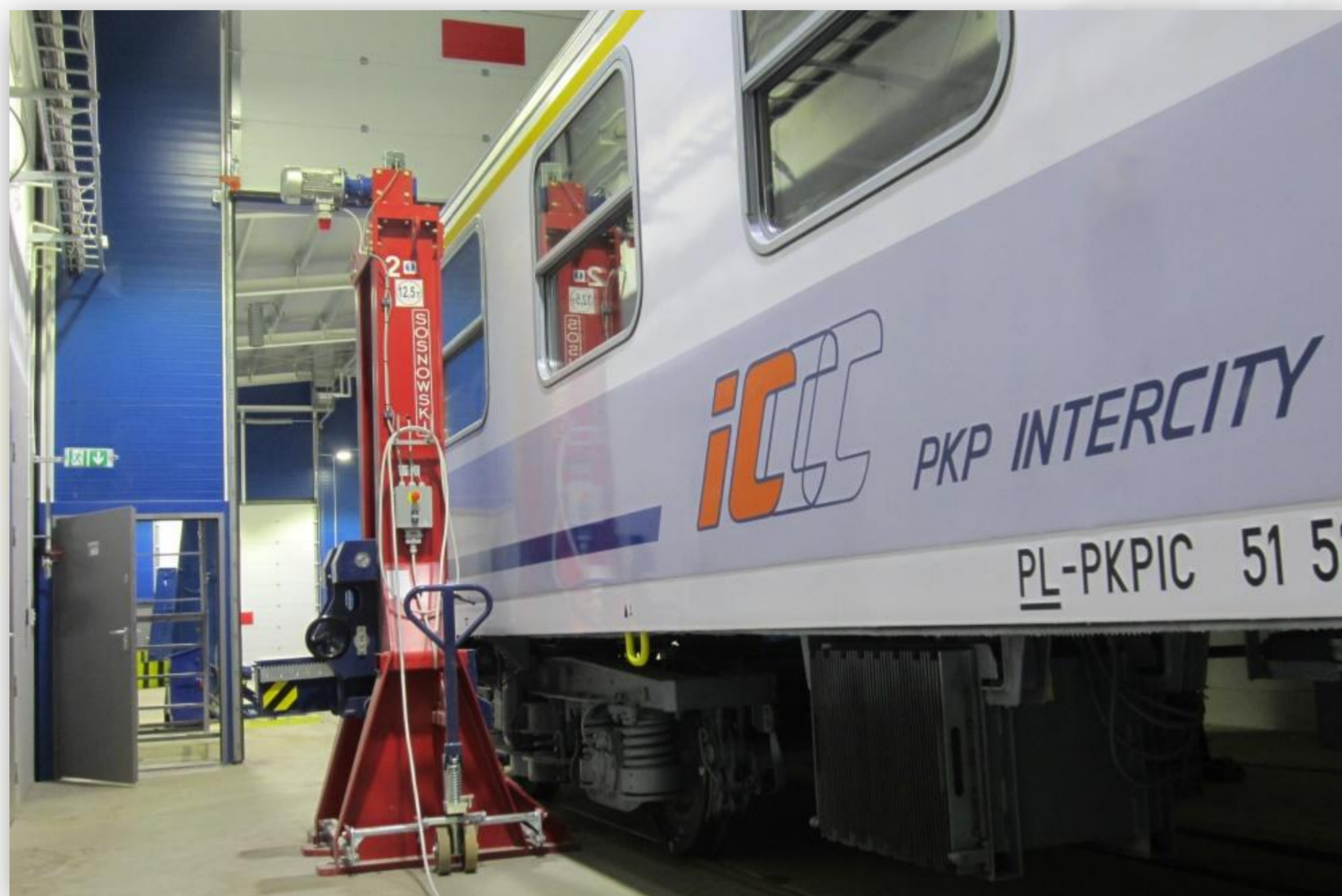
ZUT REMTRAK – Libiszów 8x12,5 t. z przesuwem poprzecznym, odbiór TDT
